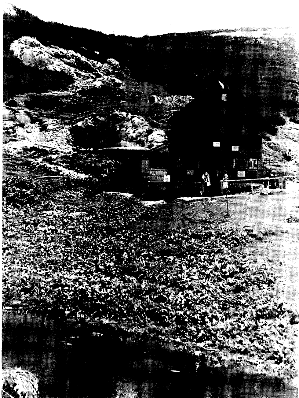
Seehütte mit Zubau
